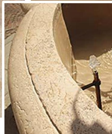
**Depósito agua impermeabilizado con membrana cementosa bicomponente elástica
