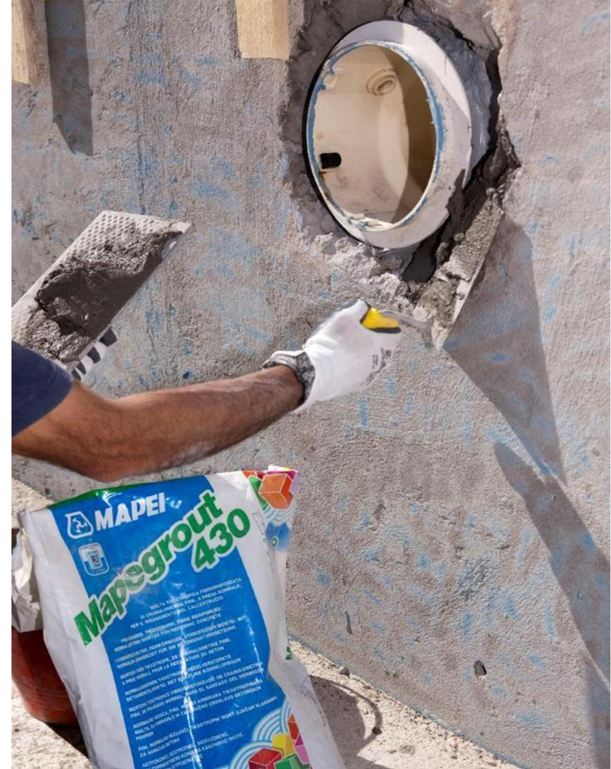
Pieza especial **Mapeband** para refuerzo de la membrana impermeable cementosa en elemento pasante.
