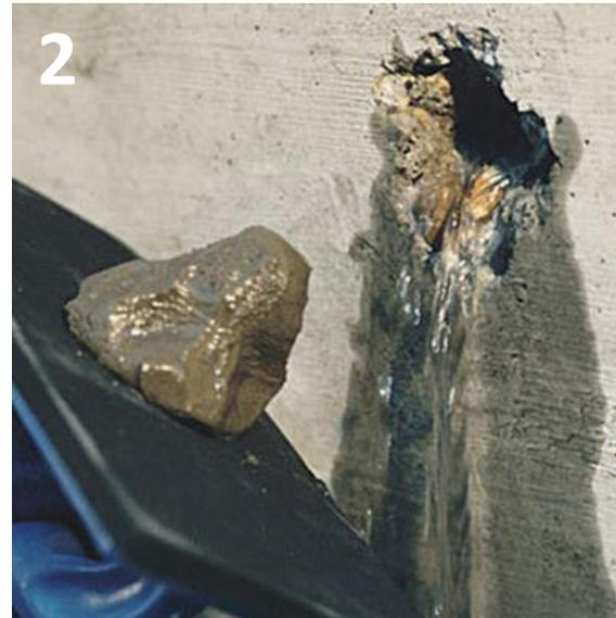
**Lamposilex:** Mortero ultrarrápido (tiempo trabajabilidad 1 min) para obturación de vías de agua.
