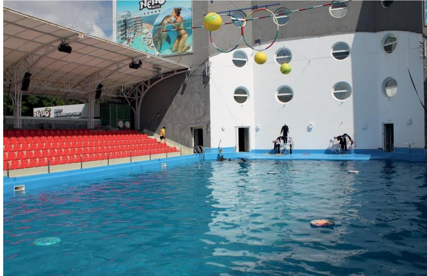
**Poliurea pura de proyección en caliente Purtop 1000: Fuente con acabado pintura Mapecoat PU 20 N (alifático)**
