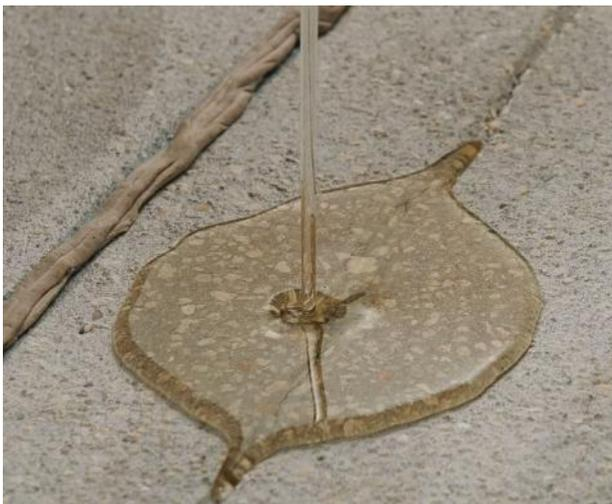
Inyección con resina epoxi Epojet o Epojet LV, o con lechada cementosa Stabilcem
