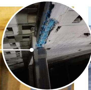
Reparación con mortero estructural Mapegrout T 40 SR / Easy Flow / T 60
