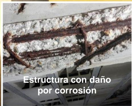
Pasivación de armaduras con Mapefer 1k
