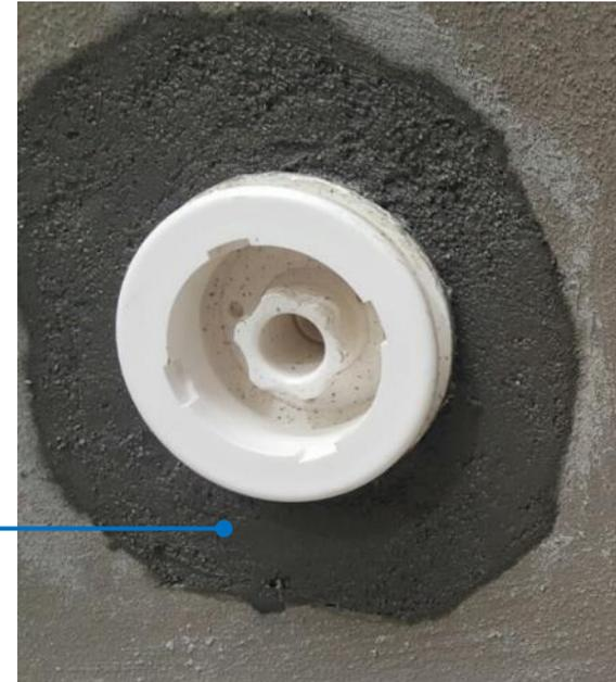
Si hay riesgo de poder afectar al tubo en el momento del repicado, el sellado se realizará superficialmente a modo de media caña mediante masilla de poliuretano [Mapeflex PU 45 FT](#), [MS 55 \(agua potable\)](#), [PU 35 CR \(alta resistencia química\)](#), etc., previo desbastado del tubo (esta técnica se aplicará también en fisuras, contorno de placas, tornillería, etc.).
