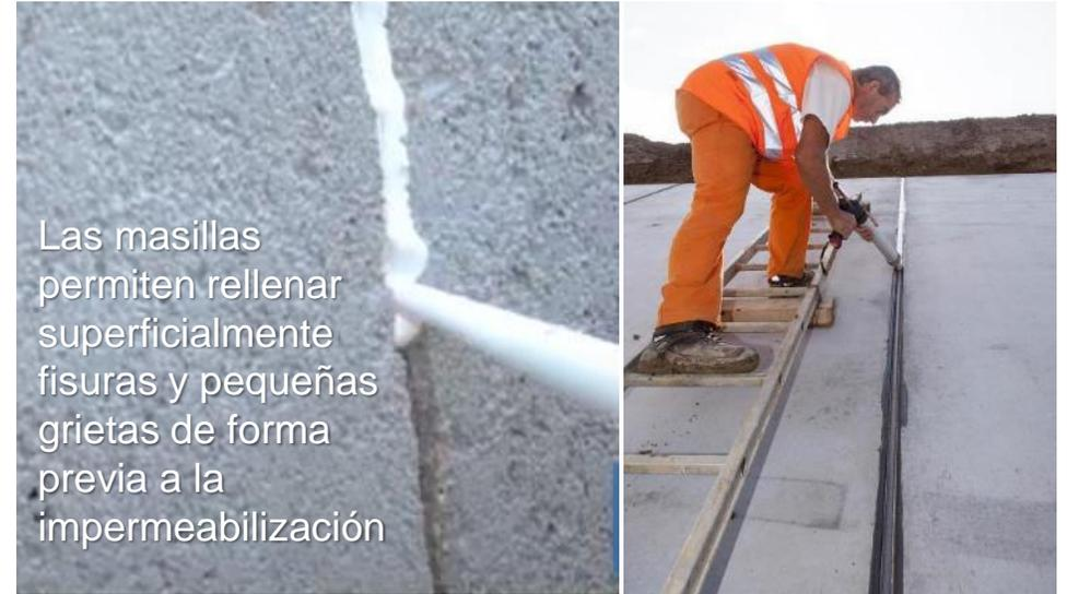
Las masillas permiten rellenar superficialmente fisuras y pequeñas grietas de forma previa a la impermeabilización
