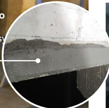
Reparaciones en estructuras de contención con morteros de reparación estructural Mapegrout
